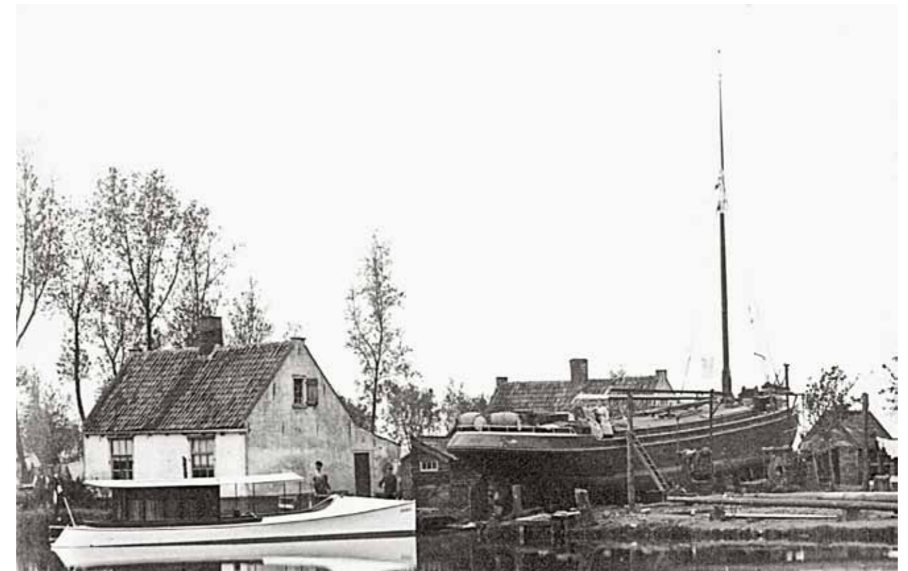
Hier begon het, op de westkant aan de Heimanswetering. In het huisje woonden de twee gezinnen van oprichters Arie en Dirk van der Laan.
